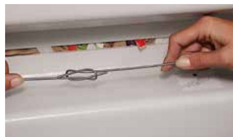
Wiązanie drutem szybkozłącznym
